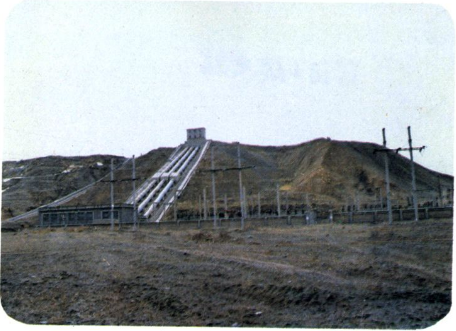
玛纳斯河三级水电站
