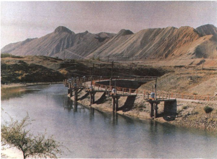
玛纳斯河渠首曲线沉砂池
