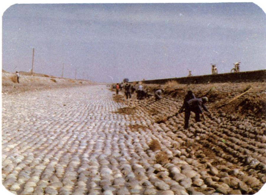
玛河东岸大渠（干砌卵石）
