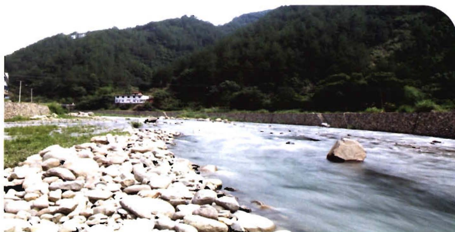
梧桐坑防洪堤
