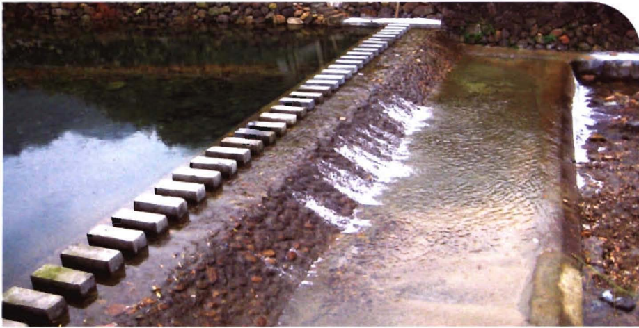
金兰坑防洪堤
