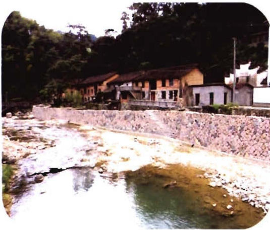
黄谢圩防洪堤
