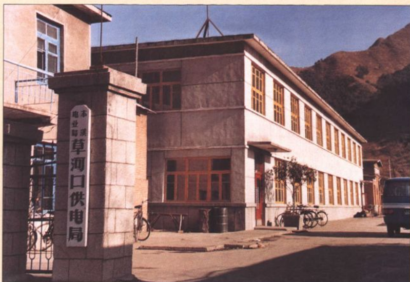
草河口供电局办公楼
