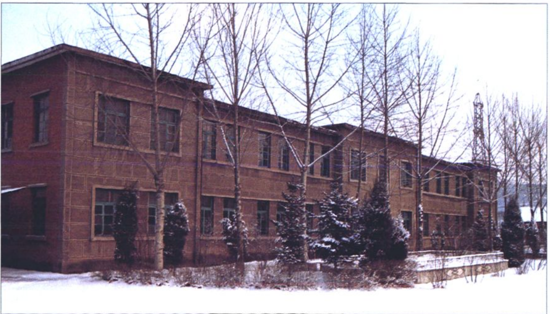
桓仁供电局办公楼
