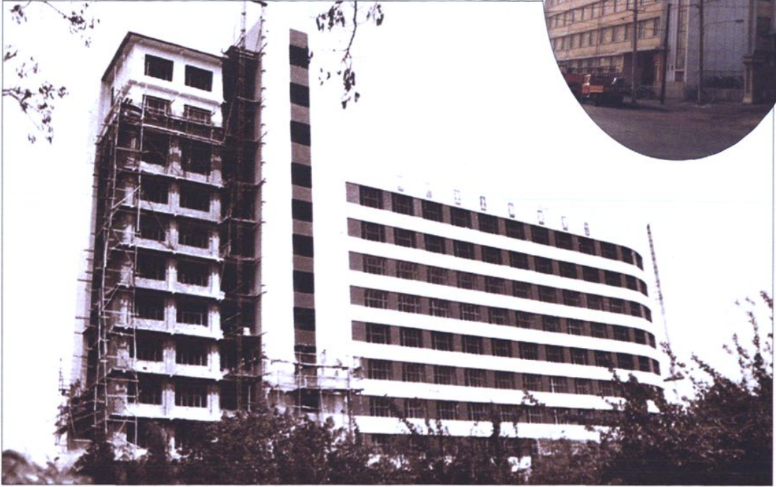
建设中的本溪电业局综合办公楼
