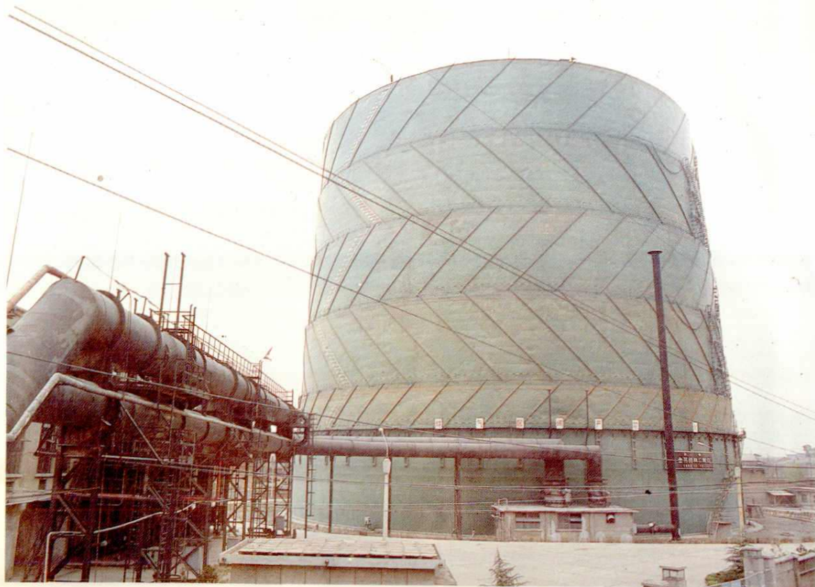
△十五万立方米高炉煤气柜
