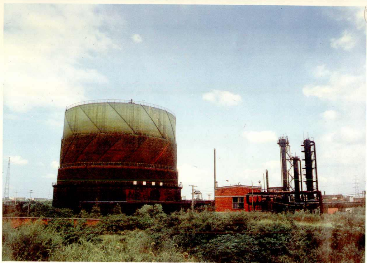
△十五万立方米高炉煤气柜
