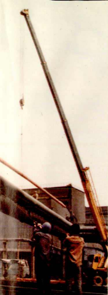
◁ 煤气管道安装
