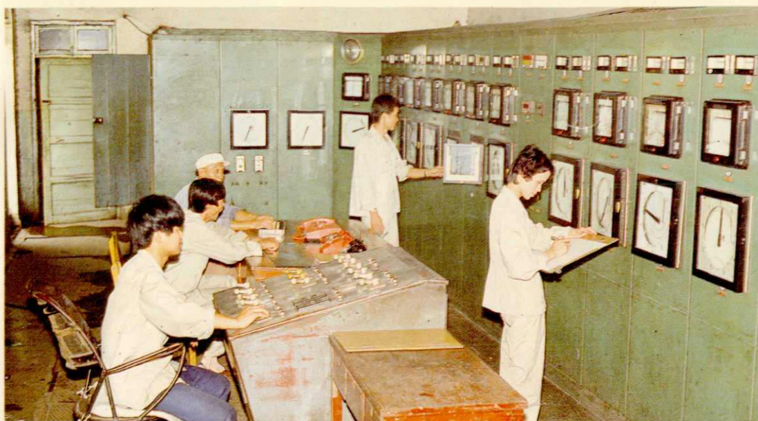
△第一煤气净化站
