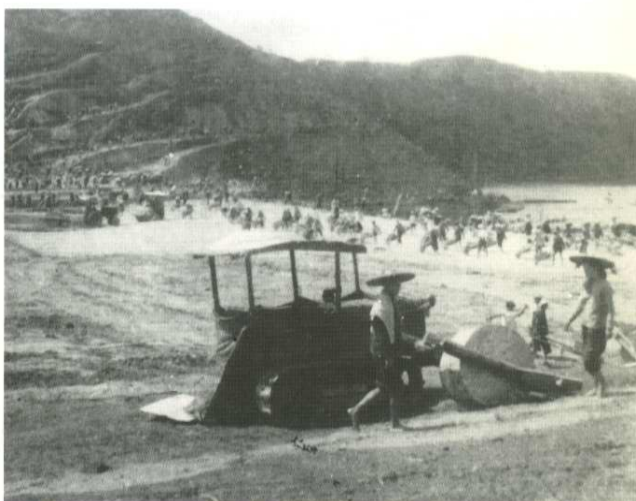
1960 年六陈水库主坝施工现场
