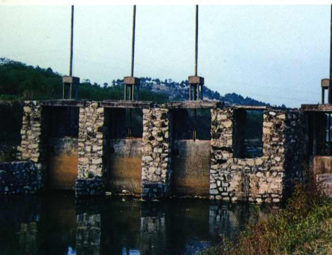
东、西干渠龙山分水闸
