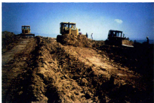
大型推土机推荒造地。
