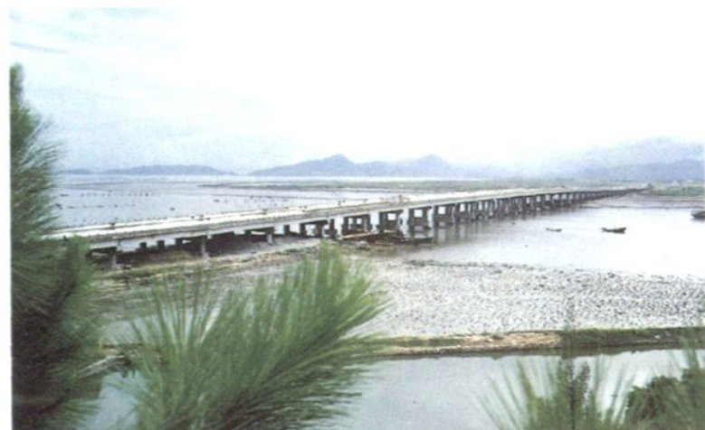
▲ 深汕高速公路長沙灣大橋
