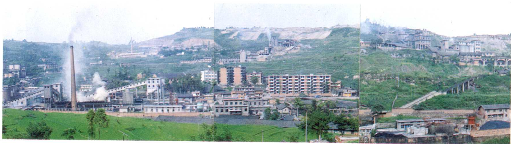
坭河洗选厂、焦化厂、水泥厂全景
