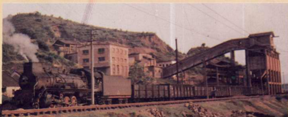
破碎厂成品矿仓
