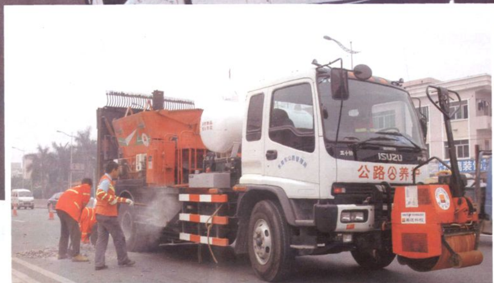
▲ 2005年引进并投入使用的先进公路养护机械——“修路王”
