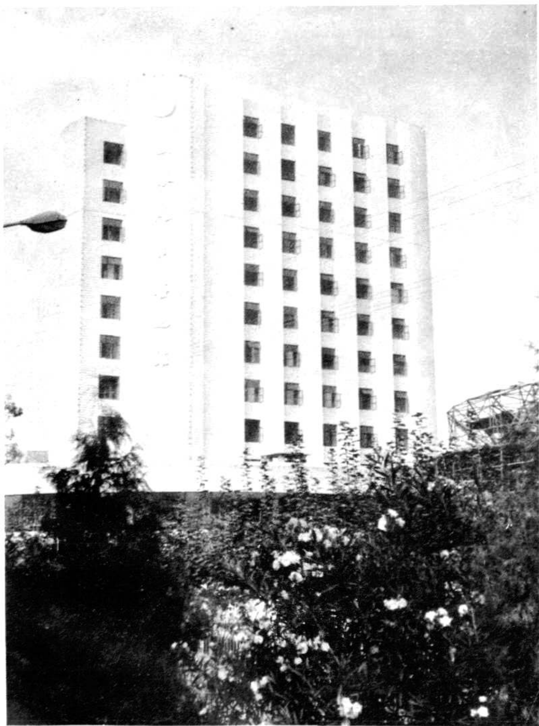
玉溪市马桥建筑公司承建的王溪汽车客运站
