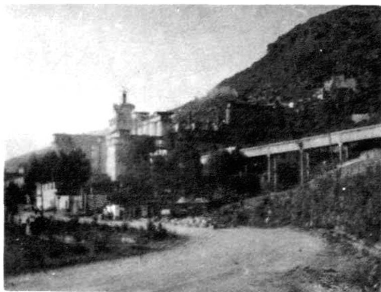
一角 玉溪市北城水泥厂厂房
