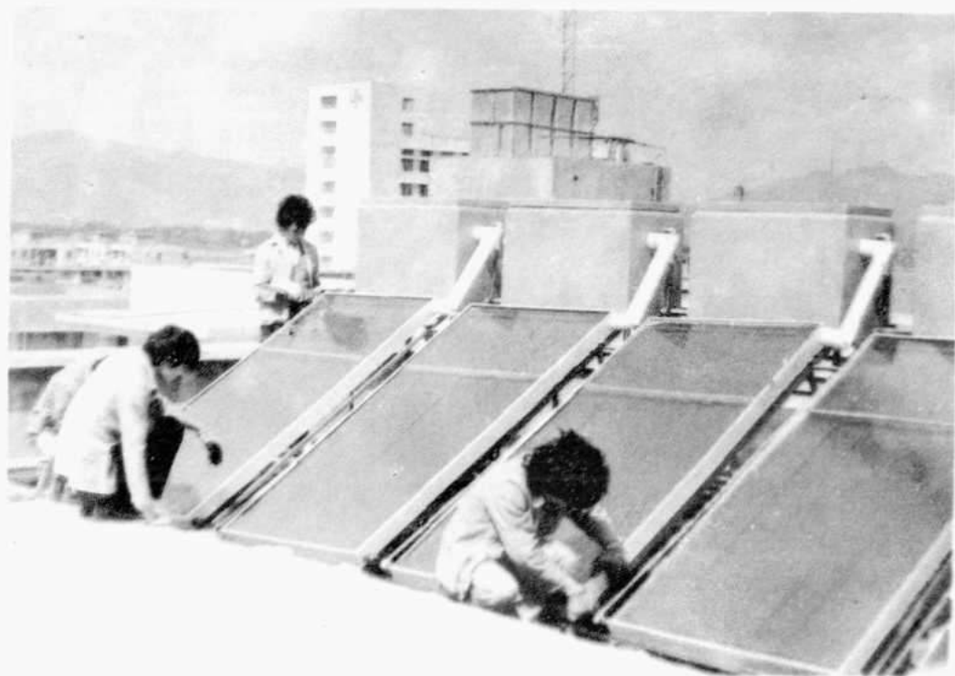
玉溪市大营街太阳能设备厂正在安装太阳能设备
