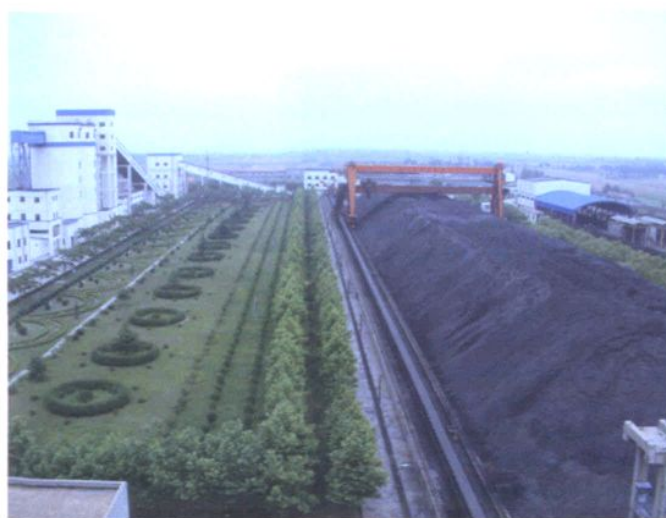
潍坊电厂 整洁美观的 花园式煤场。
