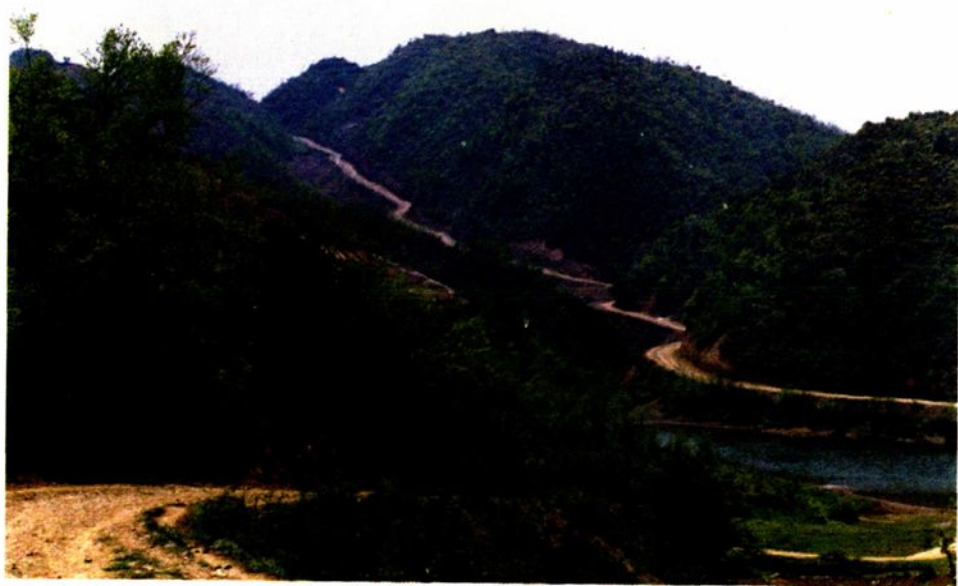
《中国 3356》项目乡村公路工程 (纳雍县乐治—蚕管)
