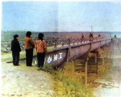
冯家山工程平渠灌溉渠道
