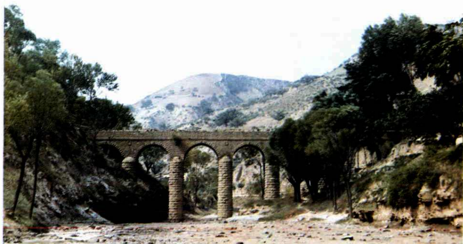
石湾一渠川岔大渡槽
