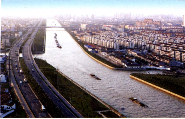
南移后的京杭运河
