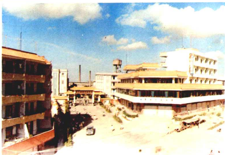
廉江烟丝厂的厂房、 办公楼、职工宿舍一角。
