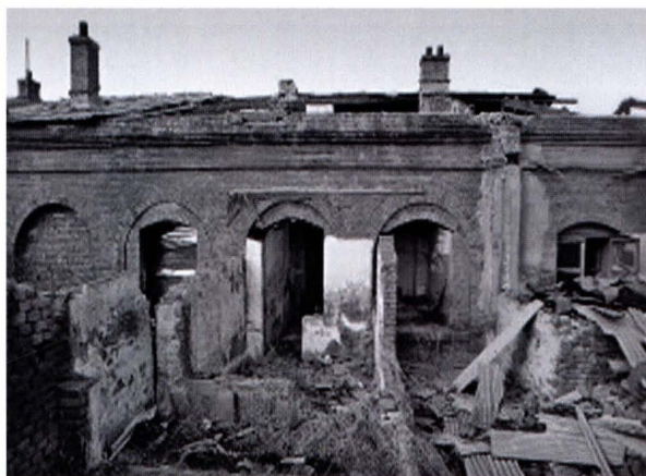
▲ 东站医院旧址
