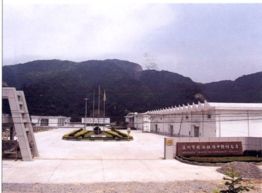
温州市粮油铁路 中转储备库(一)
