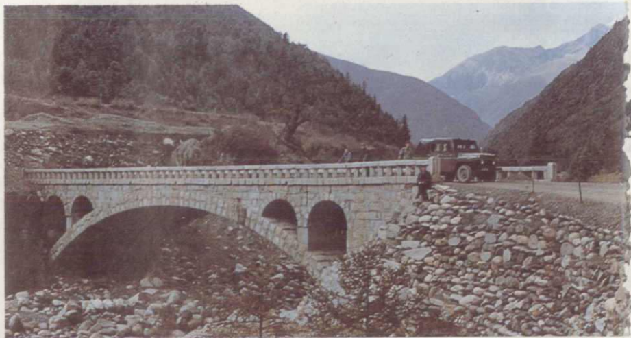
崩冲桥是我县北大门的第一座石拱桥。
