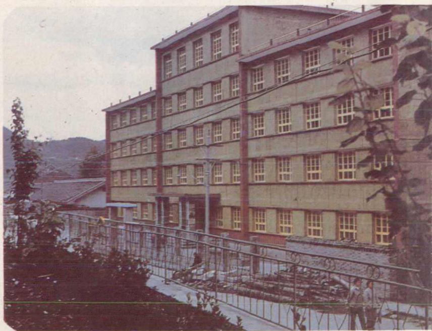
九龙县人民政府办公楼。
