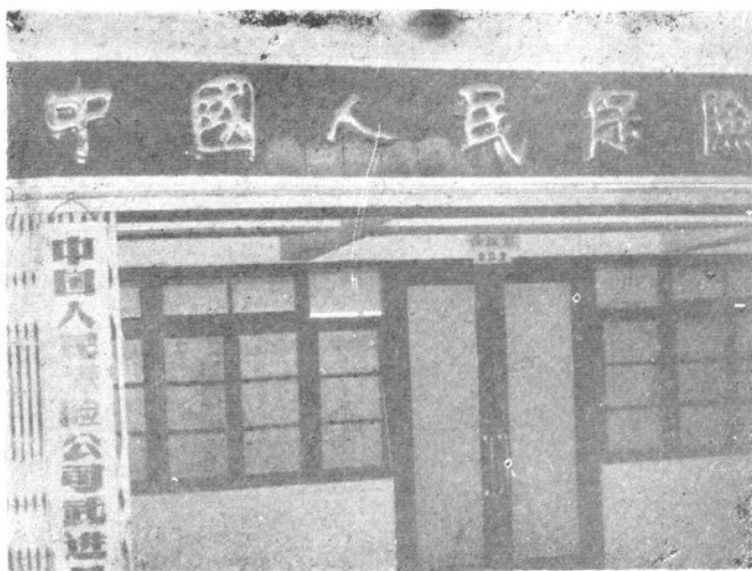
中国人民保险公司 武进县支公司 办公楼
