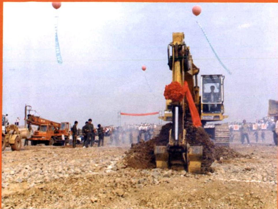
1991年12月10日，一期工程主厂房开挖第一铲
