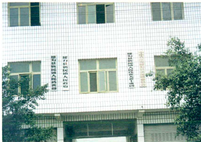
政府办公大楼
