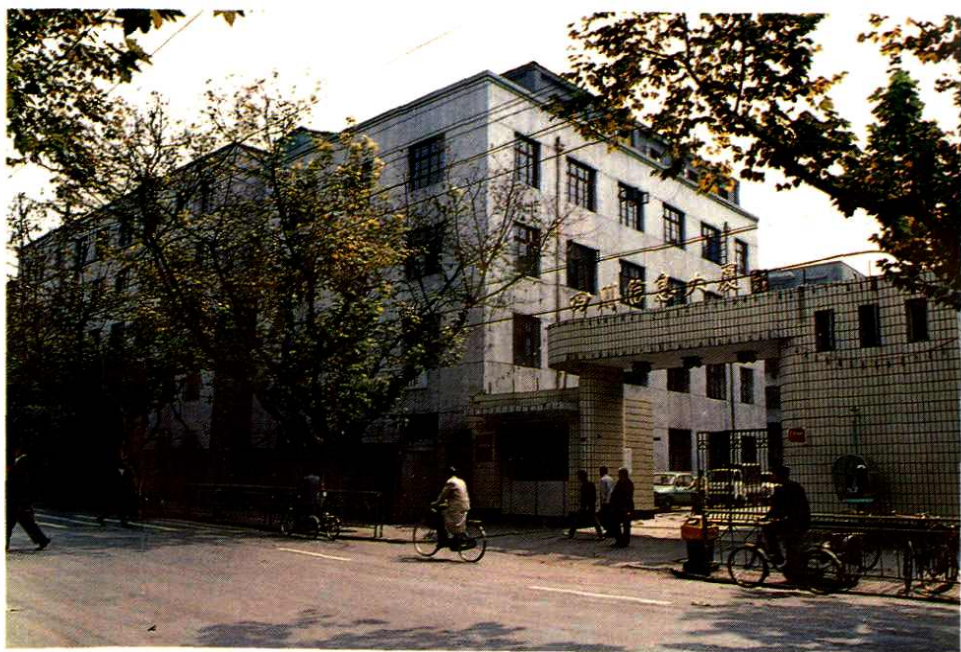
四川省统计局办公大楼
