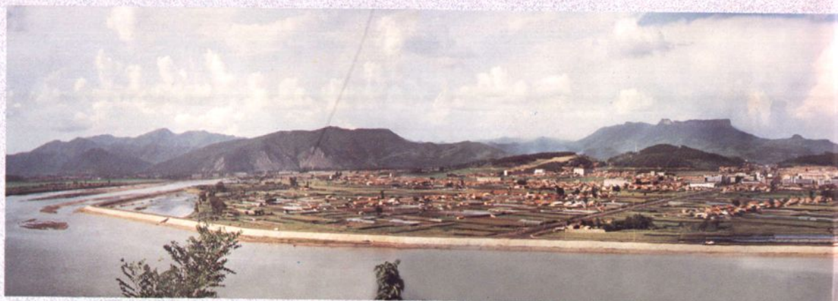
桓仁镇南江沿防洪堤
