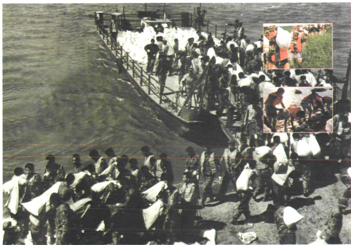
“98” 胖头泡抗洪抢险现场
