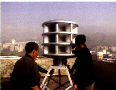
工程人员正在安装电声警报器室外扬声器，圆形、全向，功率2000W
