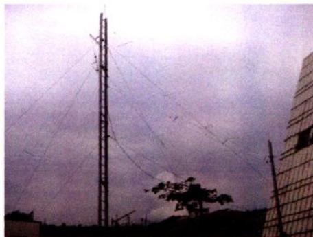
人防短波通信铁塔，已架设省、市两级短波网天线。此图为V式架设和平行架设两种方式
