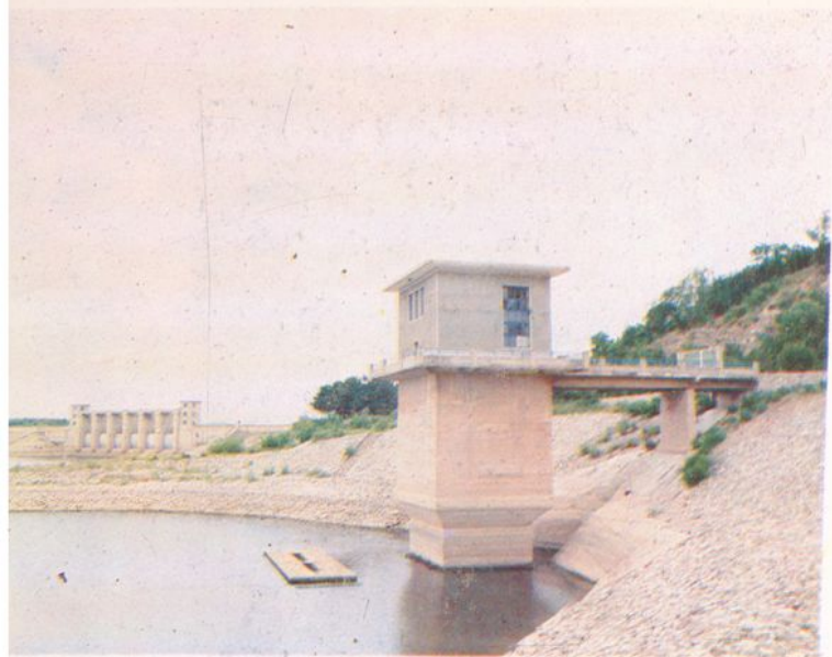
输水洞进口闸室
