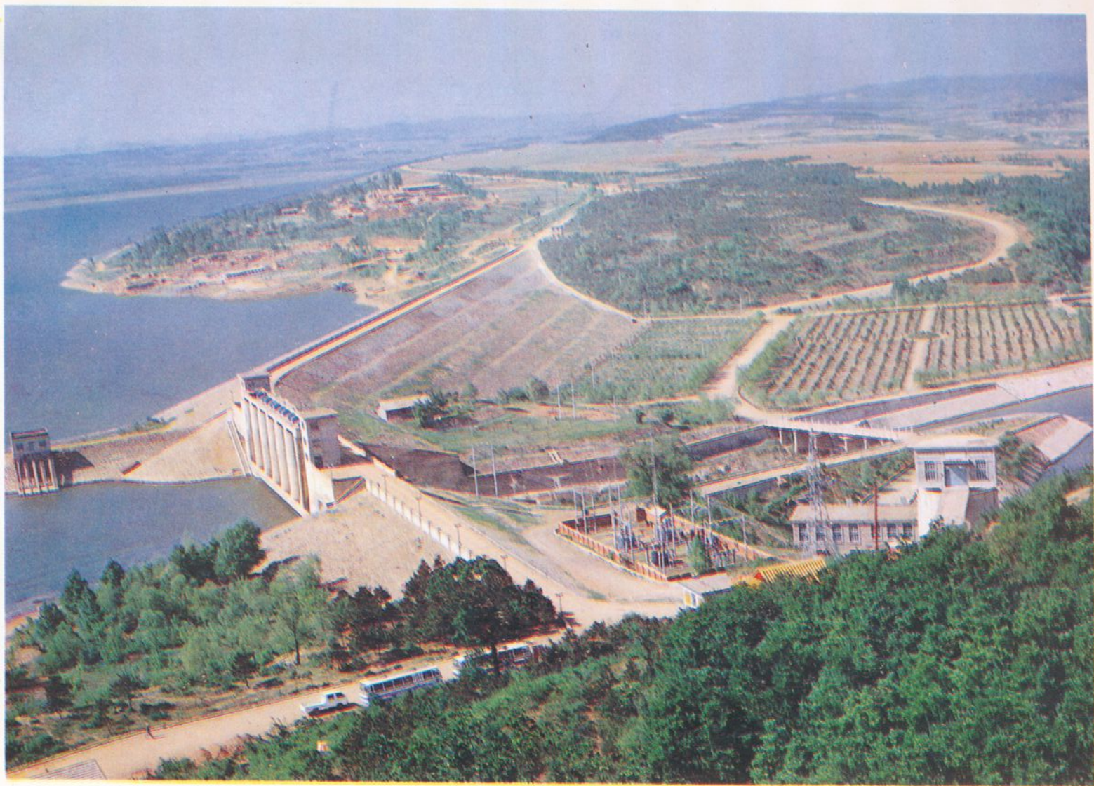
二龙山水库坝区全貌
