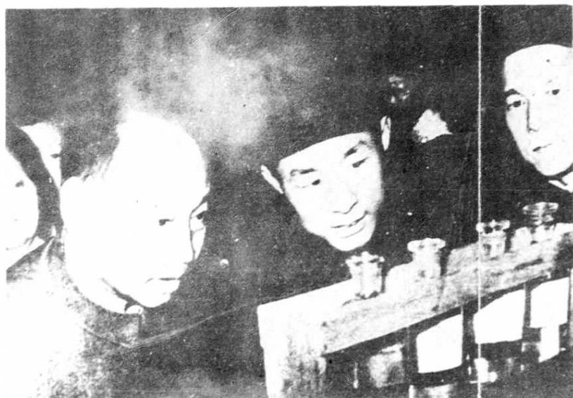
◀中共中央政治局委员、北京市市长彭真饶有兴趣地了解鸿化厂二氯甲烷生产情况
