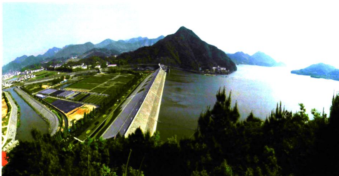
临安青山水库
