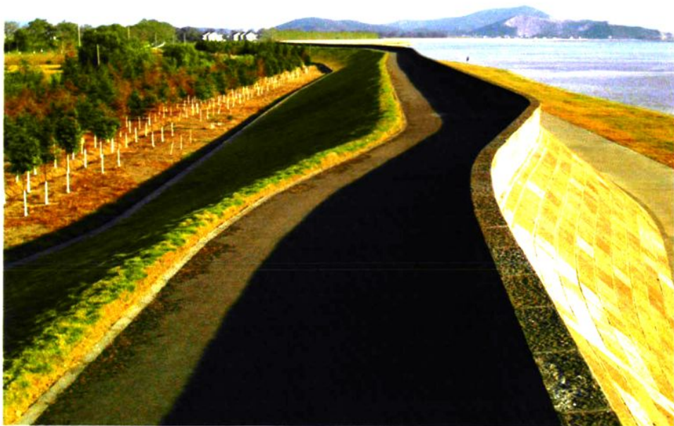
杭州钱塘江北岸险段标准海塘工程
