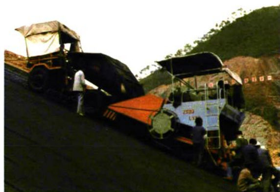
临海牛头山水库沥青混凝土摊铺施工
