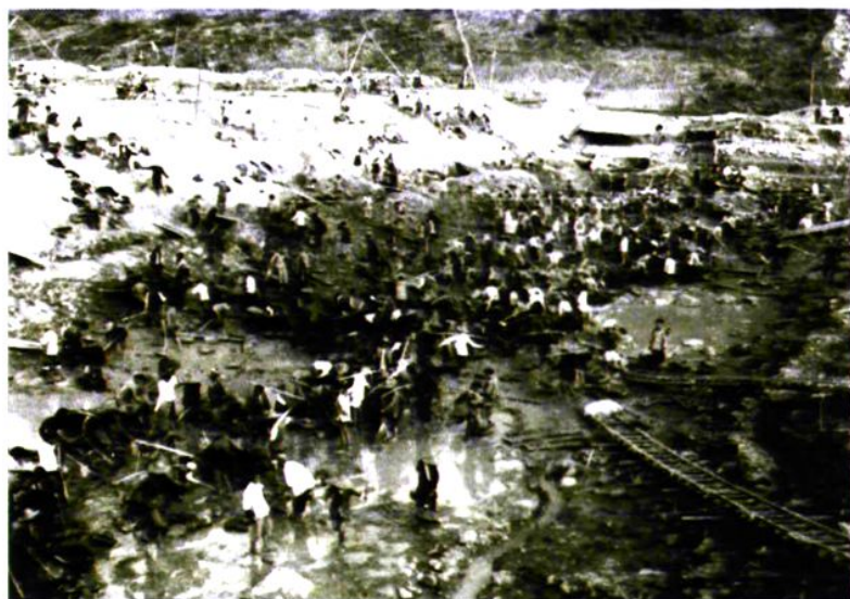
德清对河口水库施工
