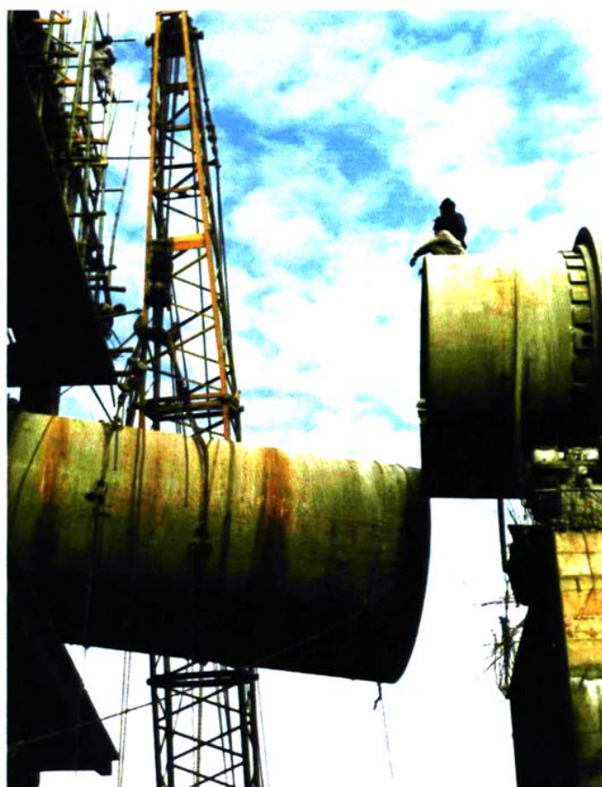
湖州长兴水泥厂二期工程施工
