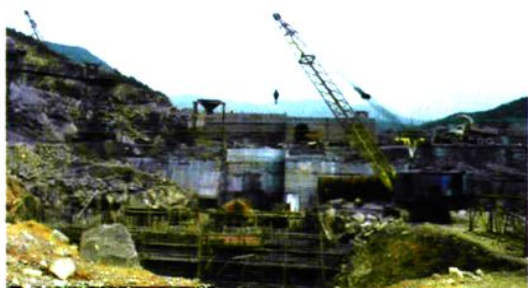
江山碗窑水库施工
