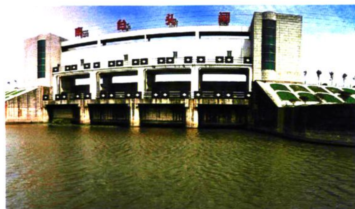
杭嘉湖南排海盐南台头闸
