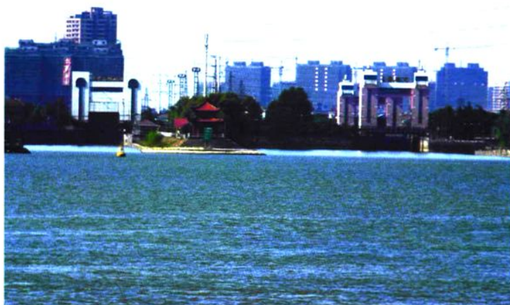
杭州三堡船闸一线、二线工程
