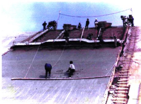
奉化横山水库扩建工程大坝混凝土防渗面板施工
