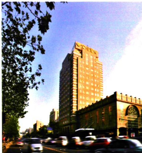
工程局新办公大楼——浙江水工大厦
