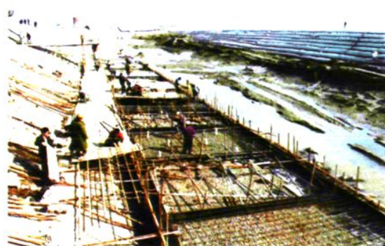
杭州钱塘江北岸险段标准海塘工程施工
