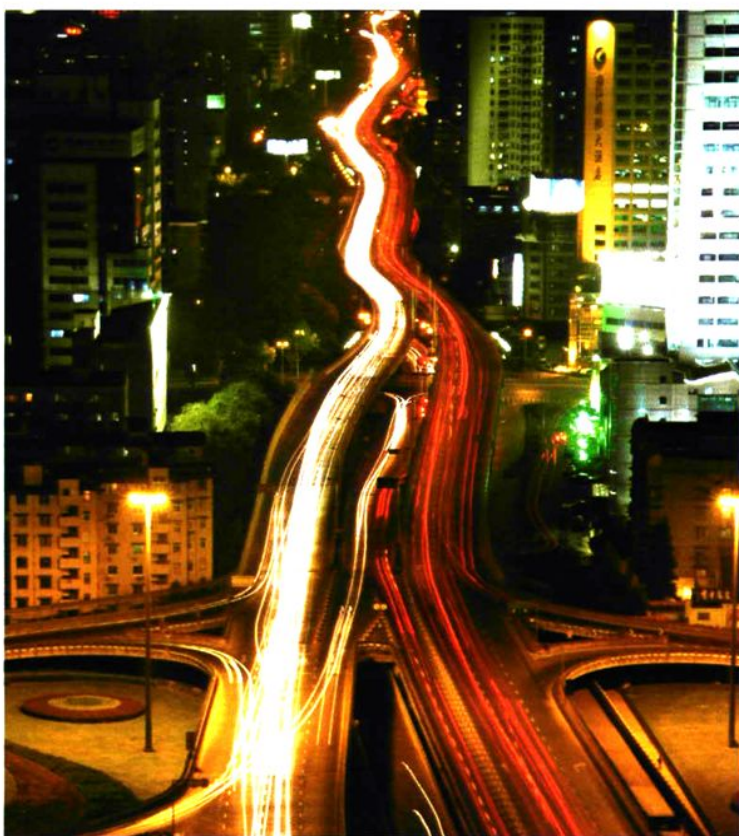
杭州中河立交桥工程
