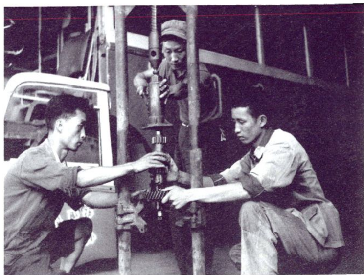
七十年代，修理工正在作业
