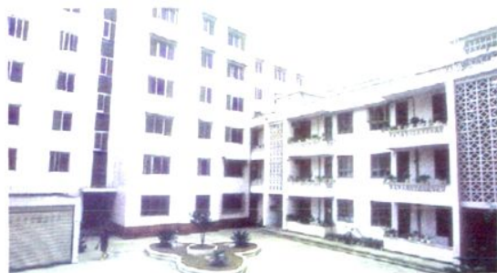
石棉县畜牧局机关职工住宅楼
