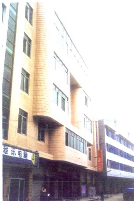
石棉县畜牧局机关办公楼
