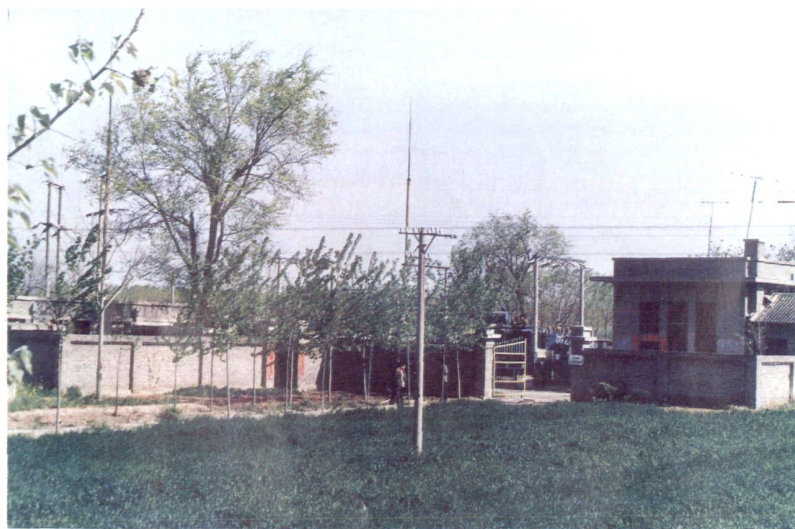
夏县大侯35千伏变电站
