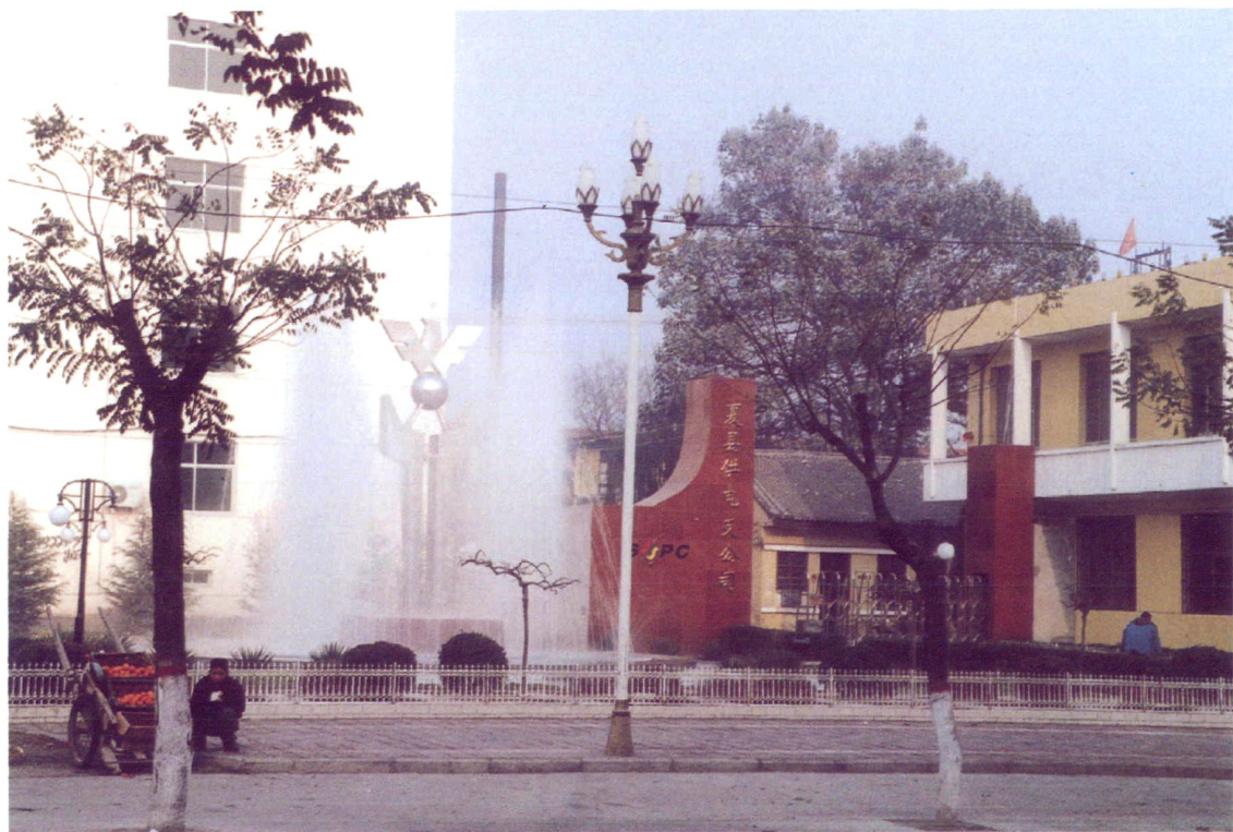
夏县供电支公司机关外貌
