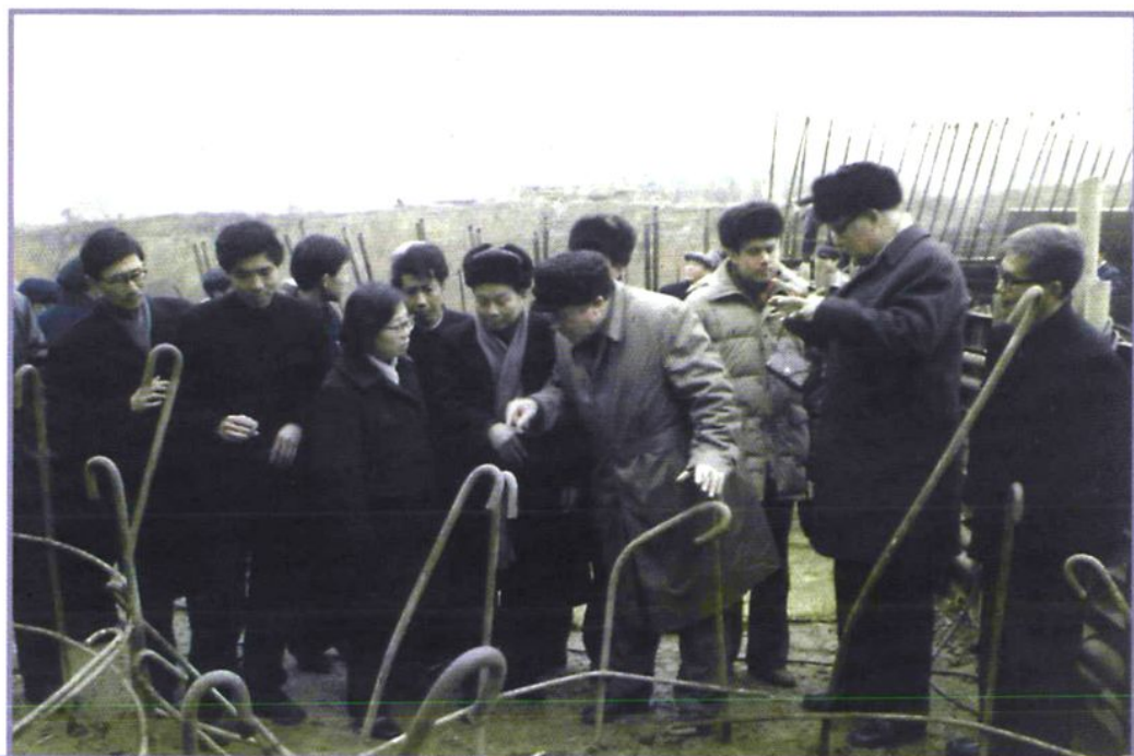
苏联动力工业部专家参观2号副坝倒挂井施工
