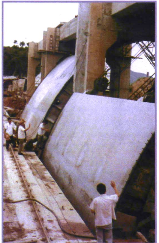
泄洪闸门安装
