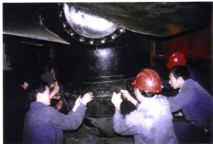
水轮机转轮组装
