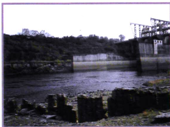
河床外露部分为主坝 下游围堰防渗墙体
