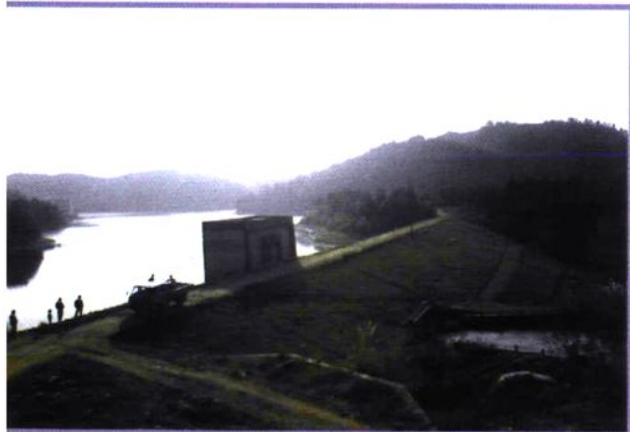
1号副坝北渠首
