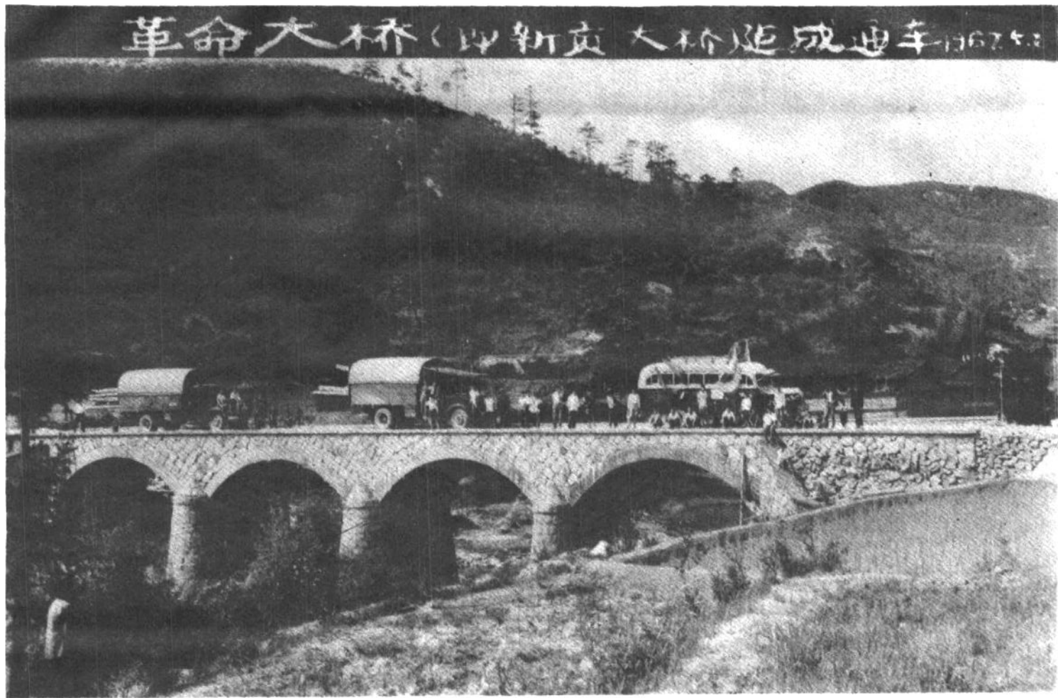
大禾线新贡桥建国后第一坐乱石拱桥
