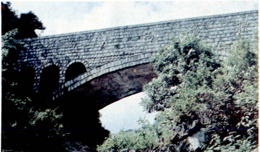
跃进水渠大治渡槽
