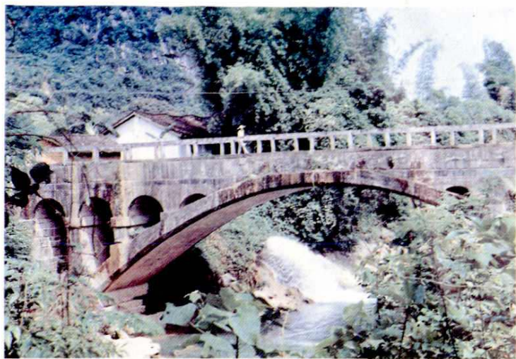
那岸渠道上利渡槽
