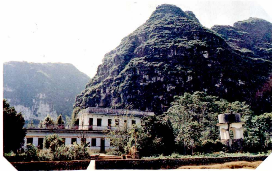
跃进水渠管护所
