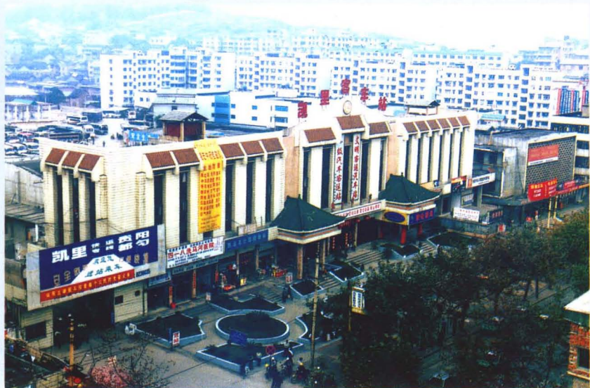
1992年2月，新建凯里客运站竣工。
