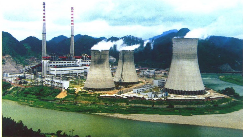
1999年12月，凯里发电厂二期技改工程完工，总装机容量达50万千瓦，时为州内最大的火电厂。
