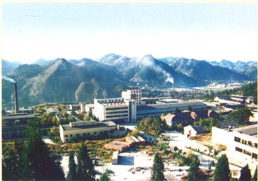
1987年10月，凯里涤纶厂建成投产，填补了贵州涤纶生产的空白。
