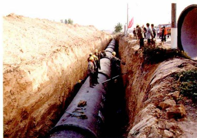
口径2200毫米球墨输水管道敷现场
