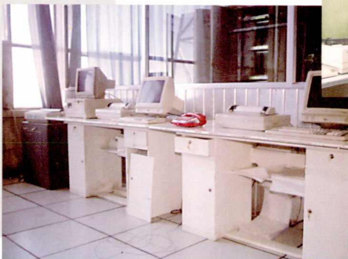
1994年竣工投产的县局程控机房。
