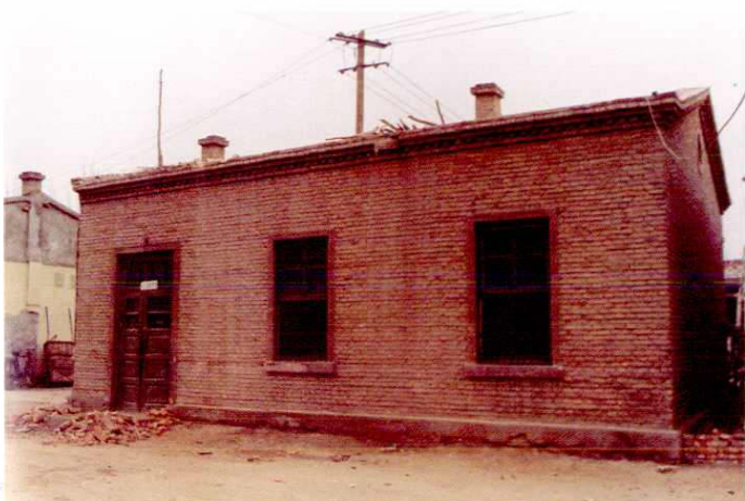
70年代建成的载波机房。
