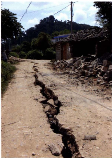
宁洱县太达村公路裂缝
