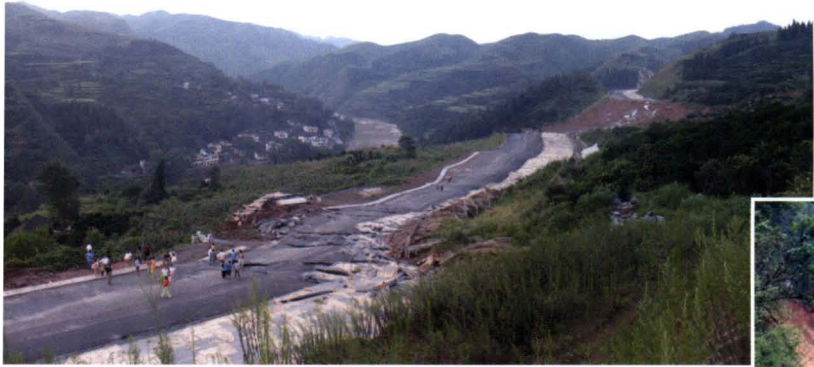
2007年7月27日凌晨1时左右，湖南省泸溪县潭溪镇朱雀洞村发生山体滑坡，通过该村的常吉高速公路450米长的道路整体下滑约5~20米，水平位移10~100米
