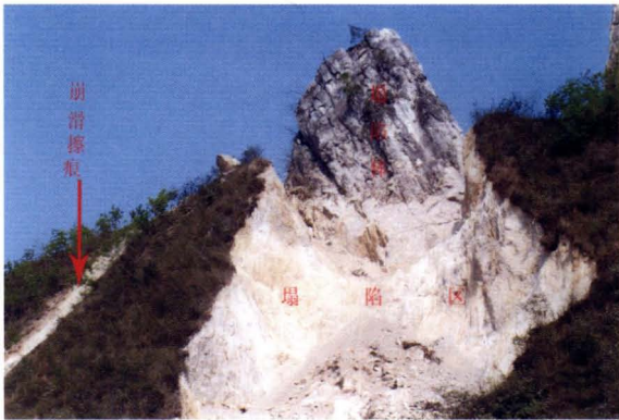
2007年3月10日，贵州省瓮安县城北西玉山镇大坪村山花组辖内的磷矿山发生崩塌灾害
