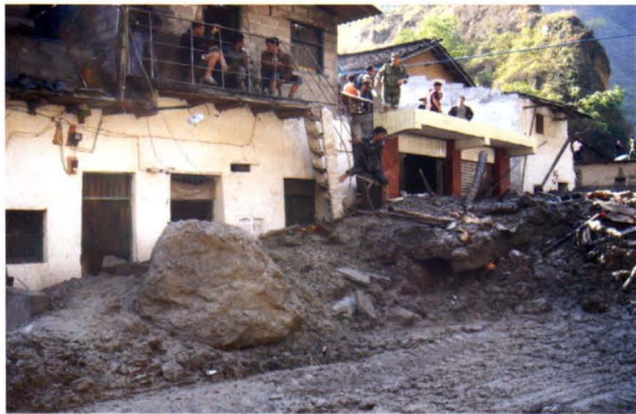
2007年5月20日，四川省雷波县莫红乡千拖村泥石流掩埋房屋、道路
