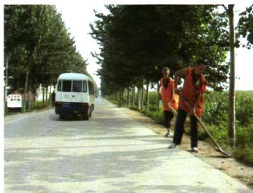
养护工人在修复路肩、清除杂草
