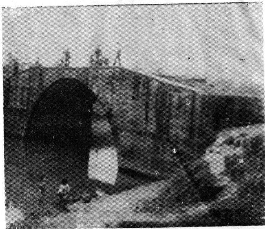
清乾隆四十七年（公元1782年）兴建的长30米、宽5米石拱结构的兴旺桥，迄今208年，仍然完好。
