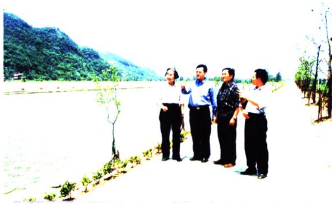
中共天柱县委、县政协领导陪同全国政协常委、黔东南州政协副主席杨念一(左一)视察天柱县城防洪堤建设工程
