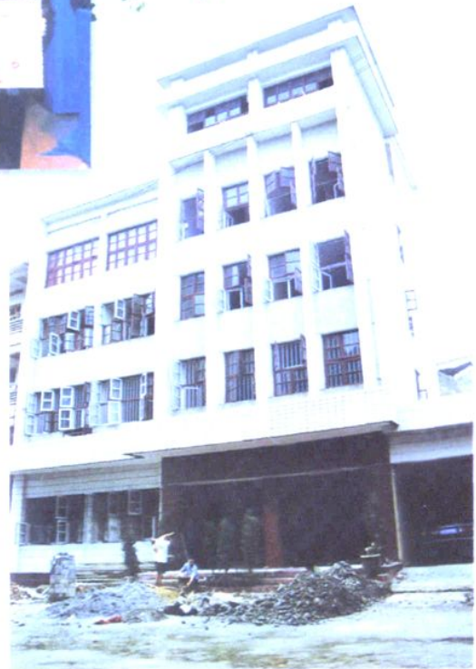
正在建设中的天柱县政协综合办公大楼
