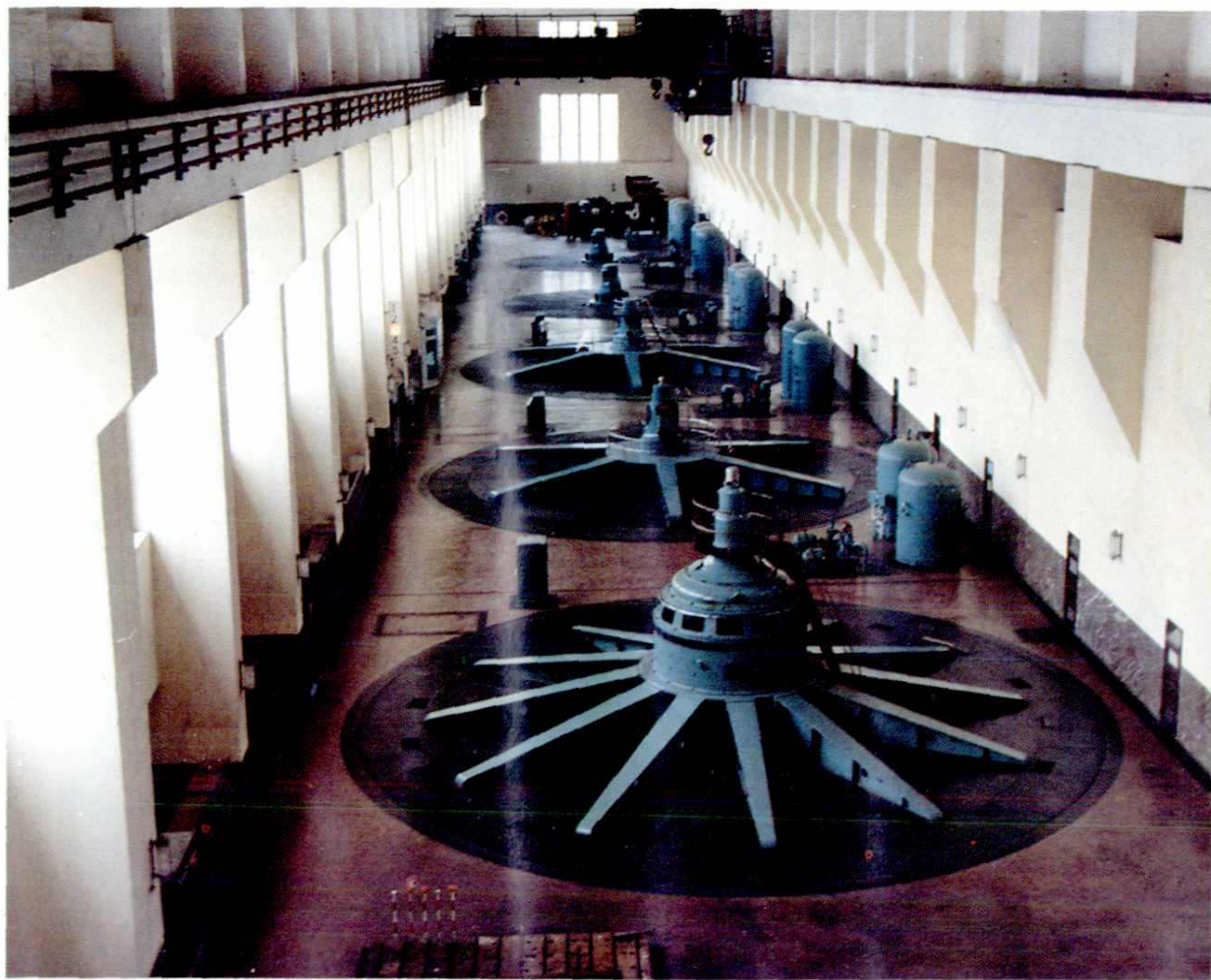
发电厂房内五台水轮 发电机组
