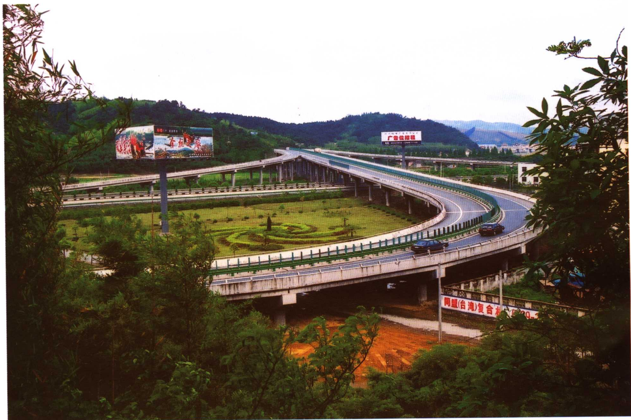
04省道彭公立交桥
