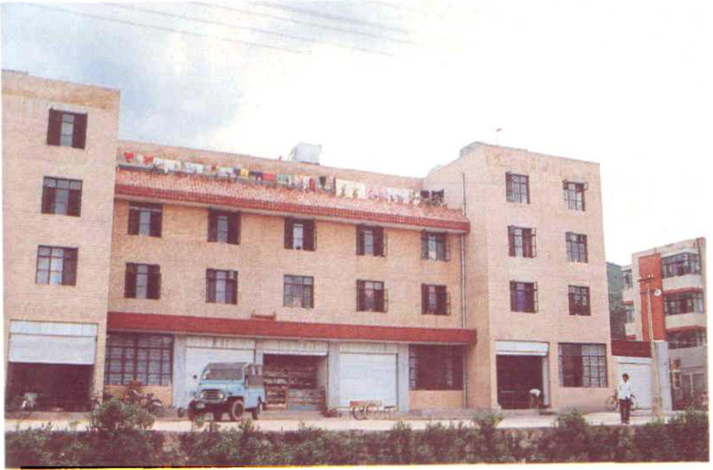
图十三：建筑公司办公楼
