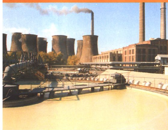
抚顺发电厂粉煤灰脱水装置
