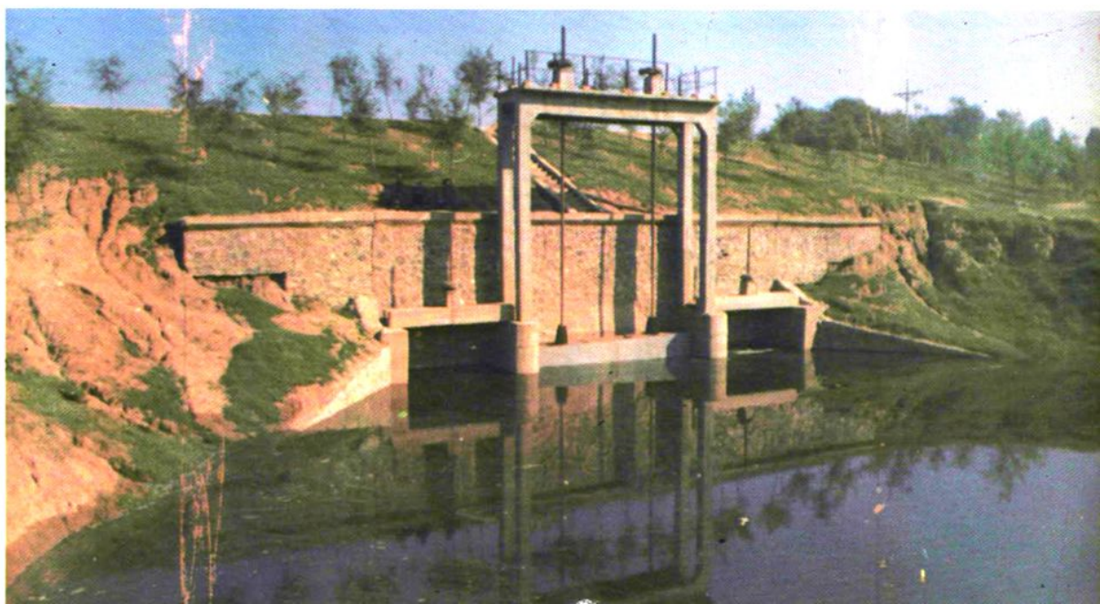
▼ 漳河左堤岸上防洪闸
