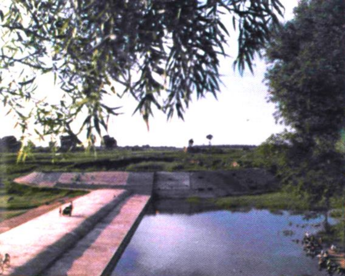
▲ 东风渠穿漳涵洞
