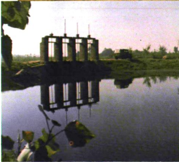
◀ 魏大馆排水渠 陈小屯节制闸
