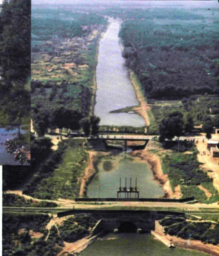
▲ 东风渠西营闸
