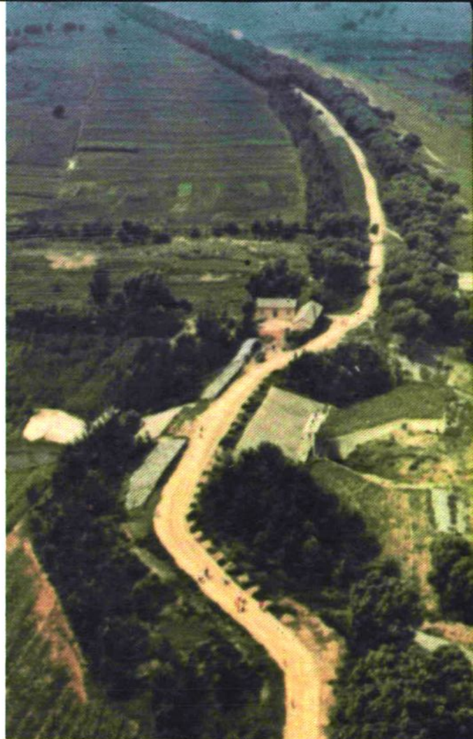
▲ 漳河右堤及东风渠穿漳工程
