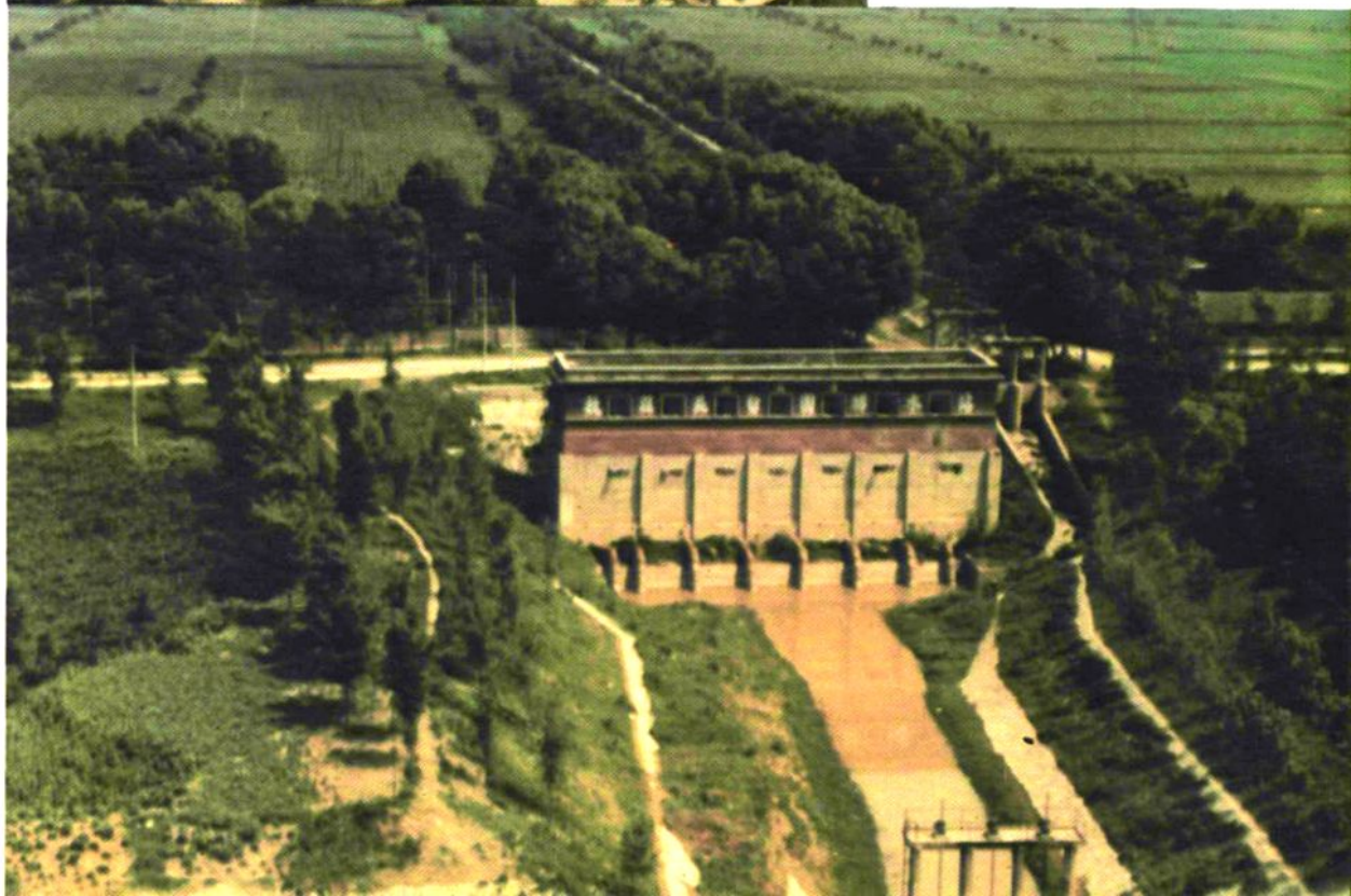
▼ 卫河留固扬水站
