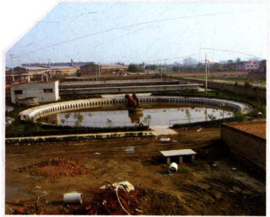
蔡伦造纸厂污水处理设施
