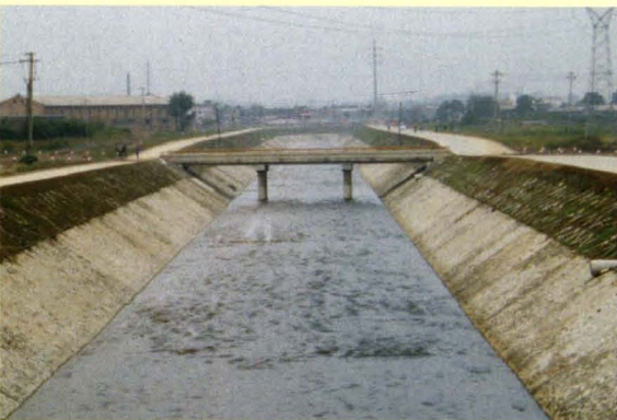
拓宽治理后的西安浐河三桥段
