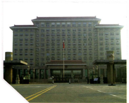
西安武警工程学院教学楼
