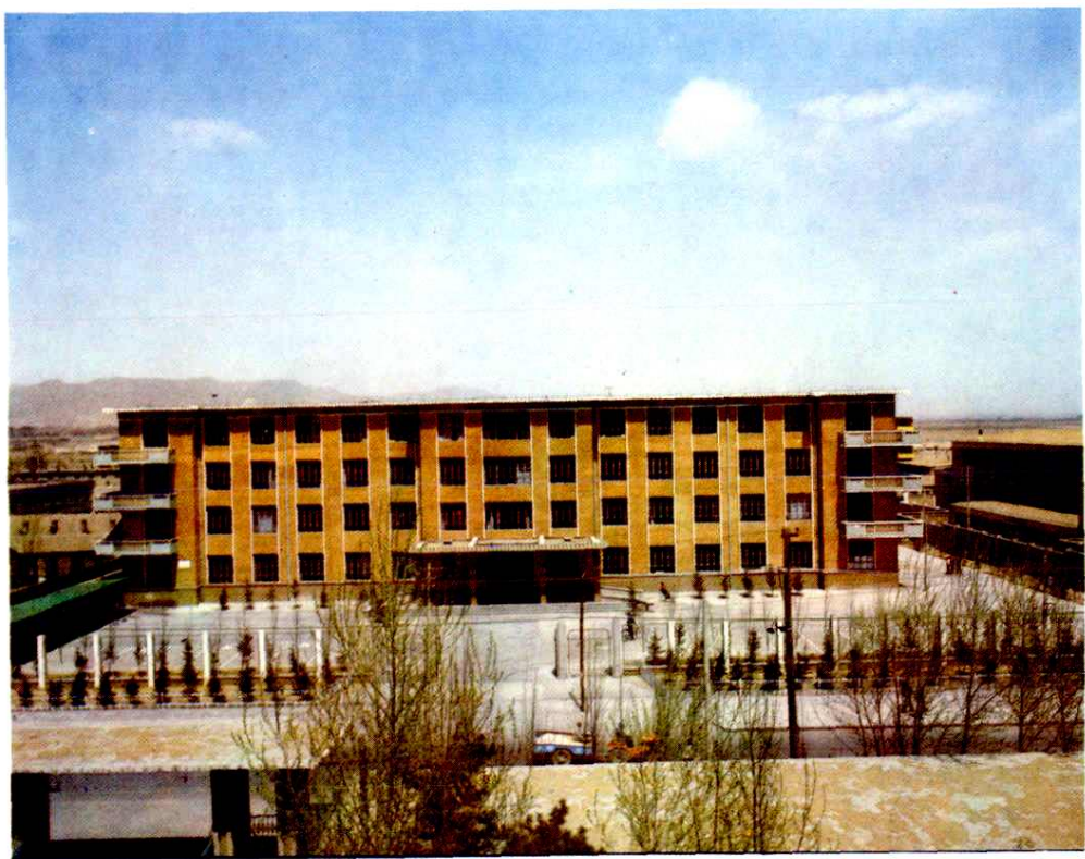
南郊区委大楼 张志诚 摄
